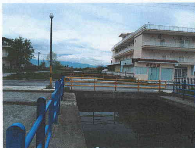
Φ3: Η απόληξη της τάφρου T6 στο λιμάνι λήψη προς τα ανάντη
